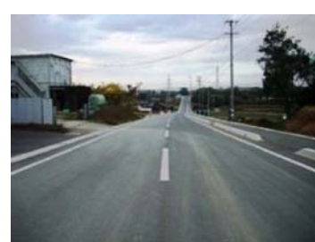
(都)大岩寺沢線の整備
