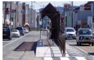
競輪場前電停整備(交通島の設置)
