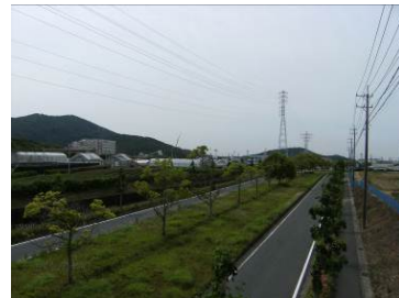
東三河環状道路の整備
