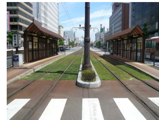
駅前大通電停で軌道緑化の実証実験
