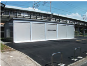
花中水防倉庫
