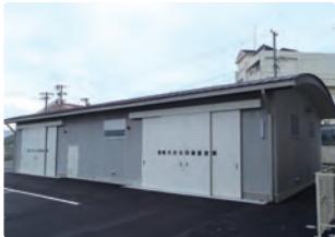
野依防災備蓄倉庫
