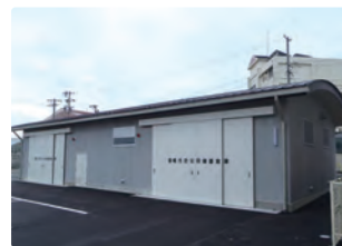
野依防災備蓄倉庫
