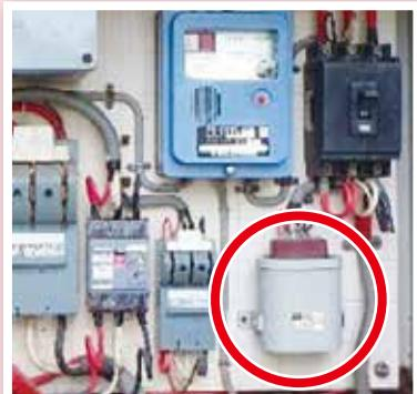
低圧分電盤内の低圧コンデンサー
