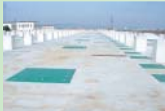
建設の進む高度処理施設
