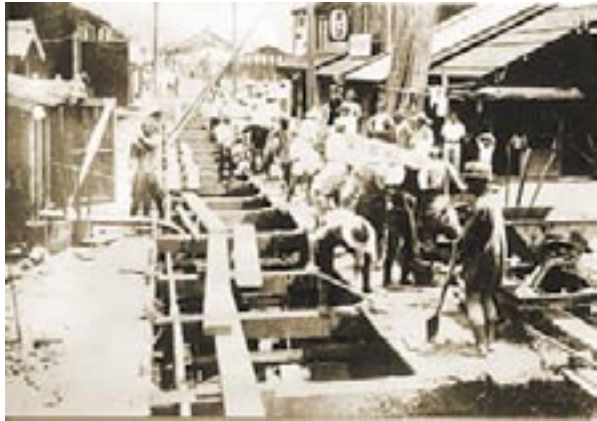
ふなまちかんせん 船町幹線工事
