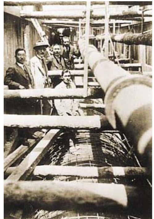
かみでんま かや 上傳馬町と萱町の工事
