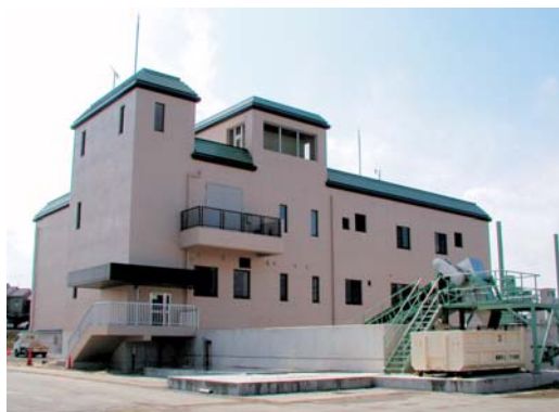
しもじ 下地ポンプ場 2005年(平成17年)3月
