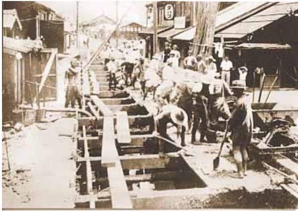
ふなまちかんせん 船町幹線工事 1933年(昭和8年)
