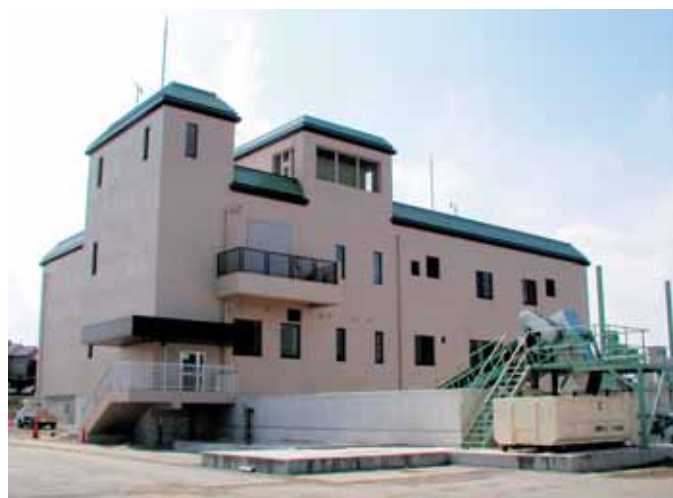
下地ポンプ場 2005年(平成17年)3月
