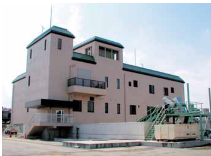
下地ポンプ場 2005年(平成17年)3月
