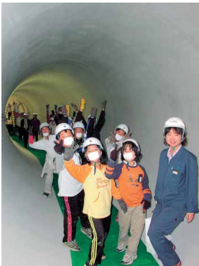
下地雨水幹線 直径3.0m 2001年(平成13年)12月
