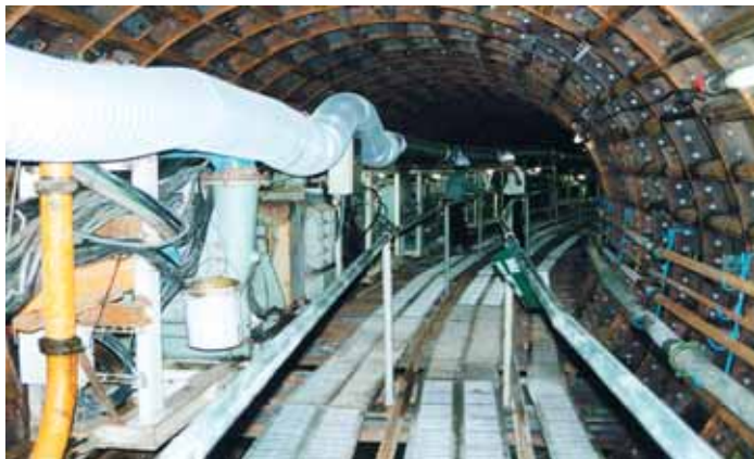
しもじうすいかんせん 下地雨水幹線工事 ちよっけい 直径3mの下水道トンネル工事 2001年(平成13年)
