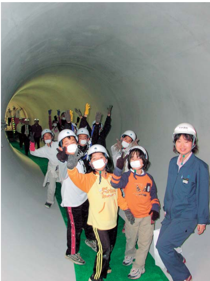
しもじ うすいせんせんちよつげい 下地雨水幹線 直径3.0m 2001年(平成13年)12月
