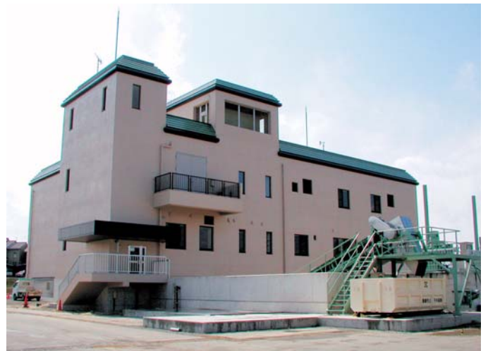
しもじ 下地ポンプ場 2005年(平成17年)3月
