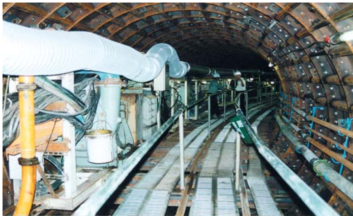
しもじうすいかんせん 2001年(平成13年) 下地雨水幹線工事 ちよつけい 直径3mの下水道トンネル工事
