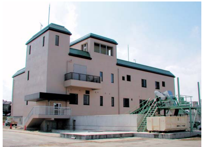
しもじ 下地ポンプ場 2005年(平成17年)3月
