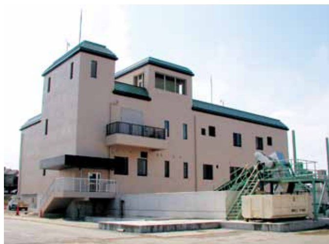
しもじ 下地ポンプ場 2005年(平成17年)3月
