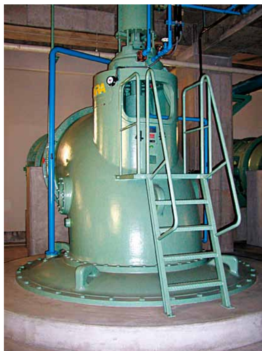
うすい 雨水ポンプ 大雨のとき、雨水をす早く汲み上げて川に放流します。
