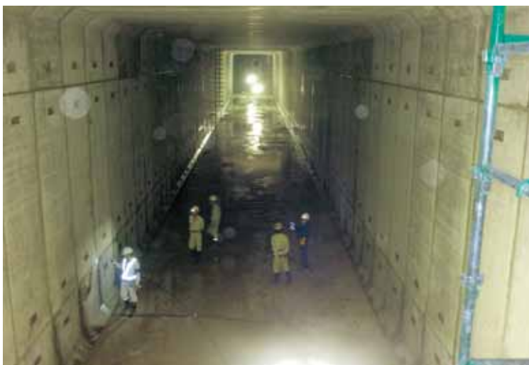
まえだみなみうすいちようせい 前田南雨水調整池 幅7m 高さ7.2m 長さ112.5m 雨水貯留容量3,600m 3 2014年(平成26年)7月
