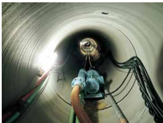
の だ なかじま おすいかんせん 2015年(平成27年) 野田・中島汚水幹線工事 ちよっけい 直径1.5mの下水道トンネル工事
