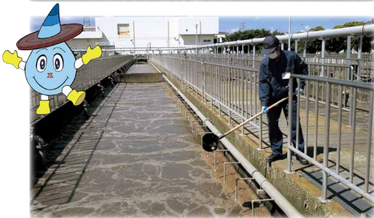
写真:上、小鷹野浄水場 下、中島処理場
