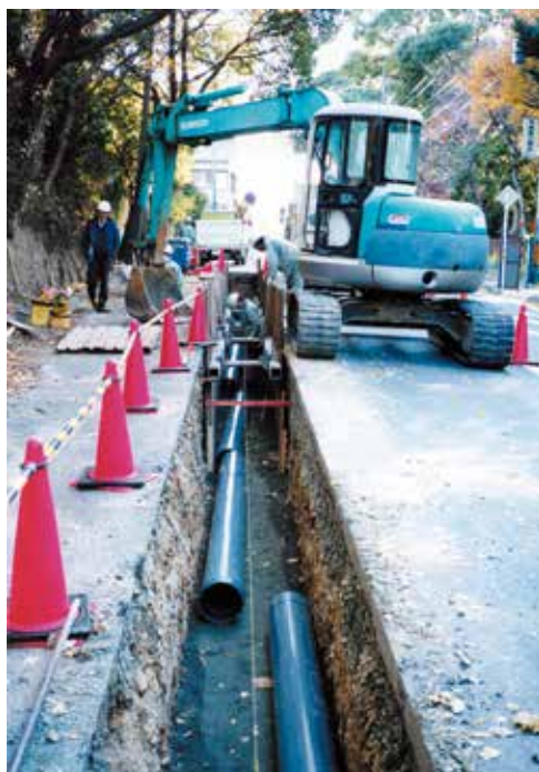
かん ちよっけい う 下水道管(直径25cm)を埋める工事
