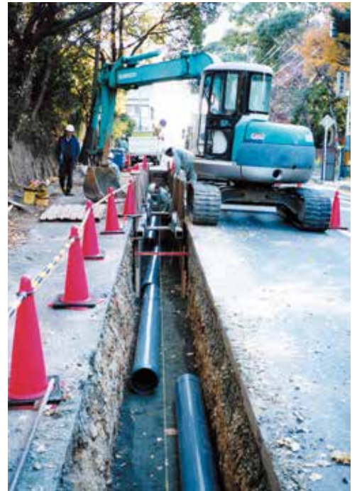
かん ちよつけい う 下水道管(直径25cm)を埋める工事
