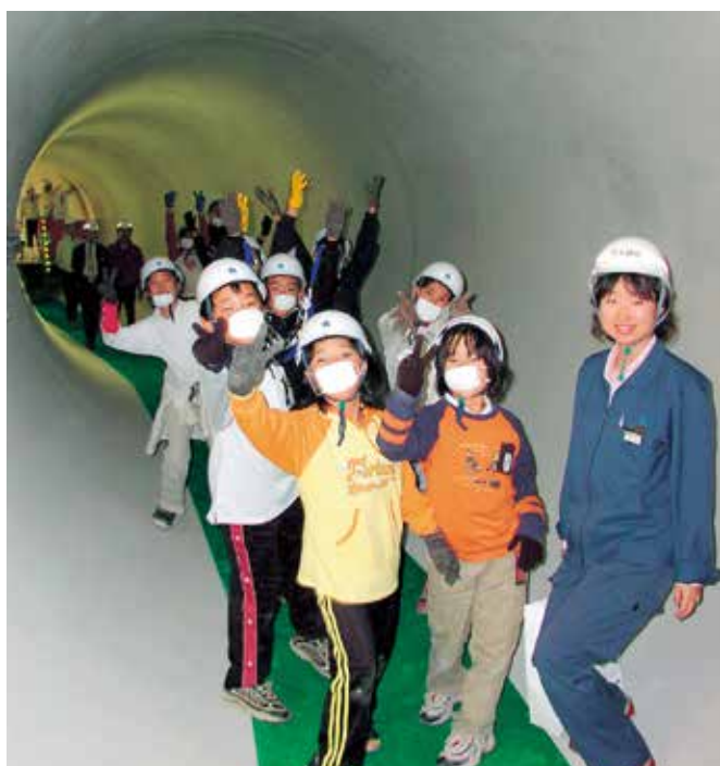
下地雨水幹線 直径3.0m 2001年(平成13年)12月
