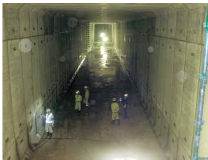
前田南雨水調整池 幅7m 高さ7.2m 長さ112.5m 雨水貯留容量3,600m 3 2014年(平成26年)7月
