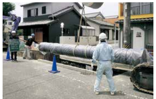
配水管を道路に埋める工事
