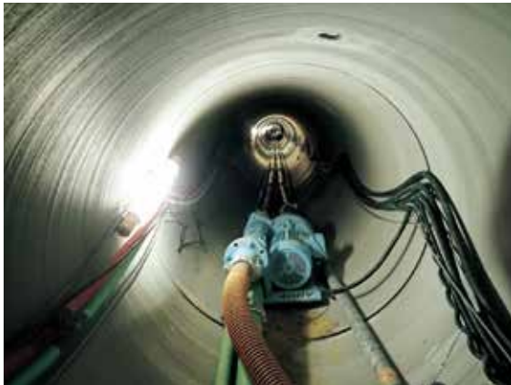
の だ なかじま おすいかんせん 2015年(平成27年) 野田・中島汚水幹線工事 ちよつけい 直径1.5mの下水道トンネル工事
