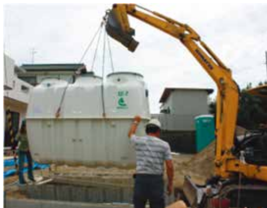
▲浄化槽を設置しているところ
