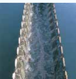
④最終沈殿池
