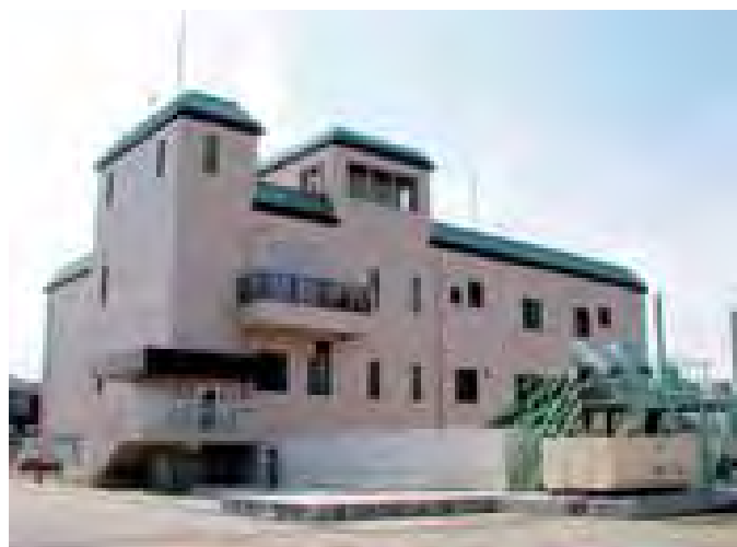
しもじ 下地ポンプ場 2005年(平成17年)3月
