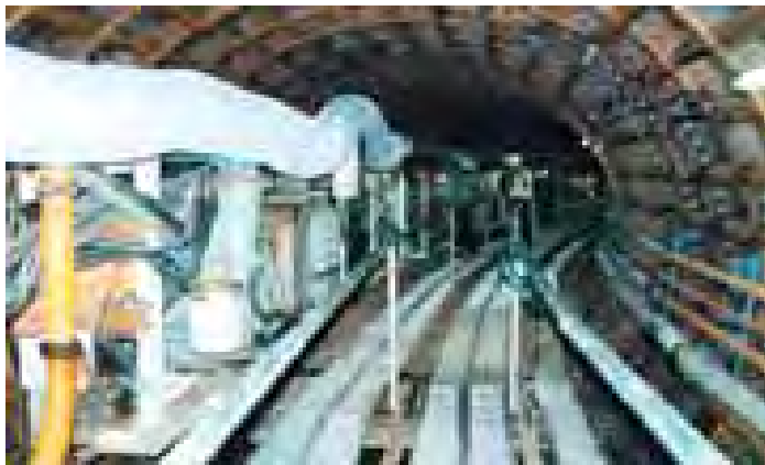
しもじうすいかんせん 2001年(平成13年) 下地雨水幹線工事 ちよっけい 直径3mの下水道トンネル工事
