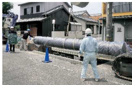
配水管を道路に埋める工事
