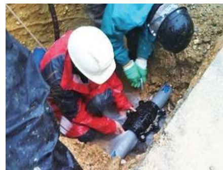
漏水修繕の様子
