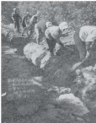
地元民も一緒に行っている水道工事の様子(昭和40年代)
