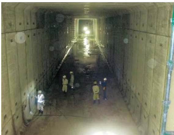
前田南雨水調整池 幅7m 高さ7.2m 長さ112.5m うすいちりゆうようりやう 雨水貯留容量3,600m 3 2014年(平成26年)7月
