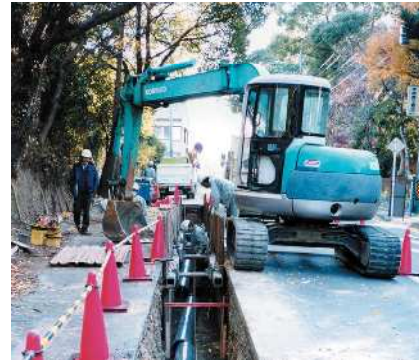
かん ちよっけい う 下水道管(直径25cm)を埋める工事
