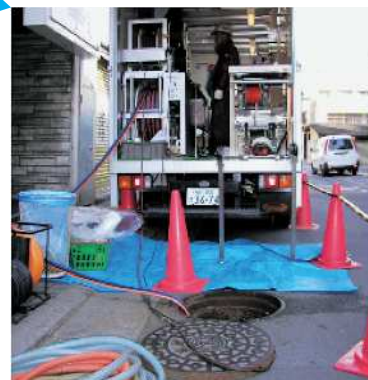
▲下水道管の修理
