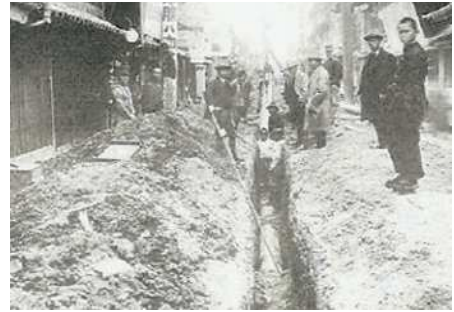
札幌通りでの水道工事の様子(昭和2年ごろ)
