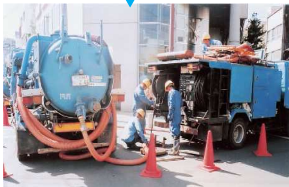
▲下水道管の清掃
