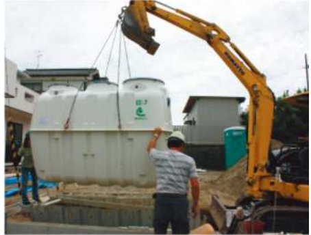
▲浄化槽を設置しているところ
