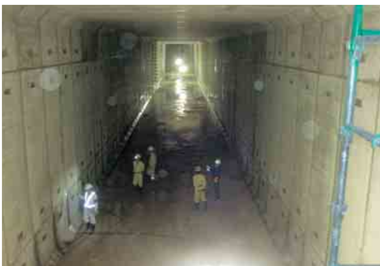
前田南雨水調整池の内部 2014年(平成26年)7月
