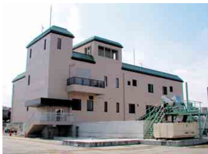
下地ポンプ場 2005年(平成17年)3月
