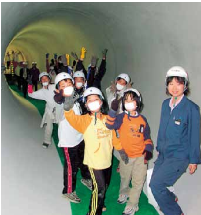
下地雨水幹線 直径3.0m 2001年(平成13年)12月
