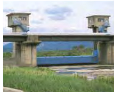
豊川放水路分流堰
