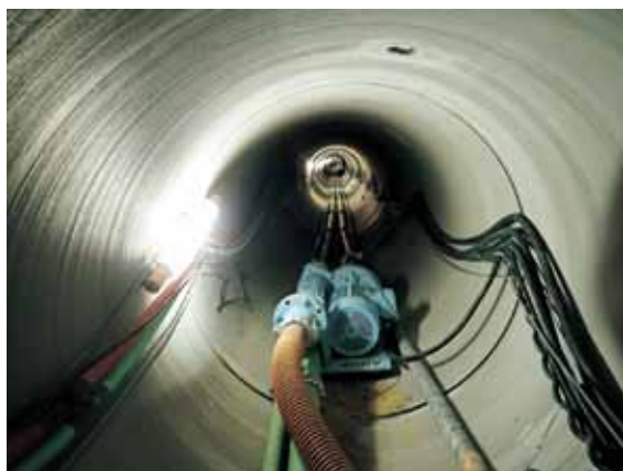
の だ なかしまおすいかんせん 2015年(平成27年) 野田・中島汚水幹線工事 ちよっけい 直径1.5mの下水道トンネル工事
