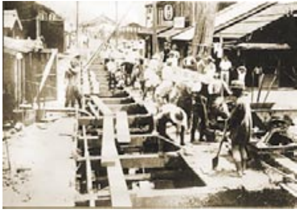
ふなまちかんせん 船町幹線工事
