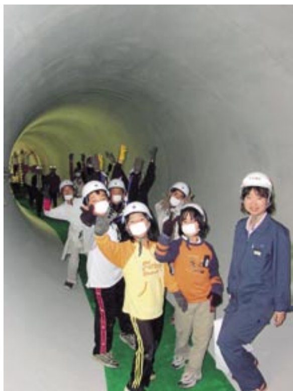
下地雨水幹線 しもじうすいかんせん 直けい3.0m（H13年12月）
