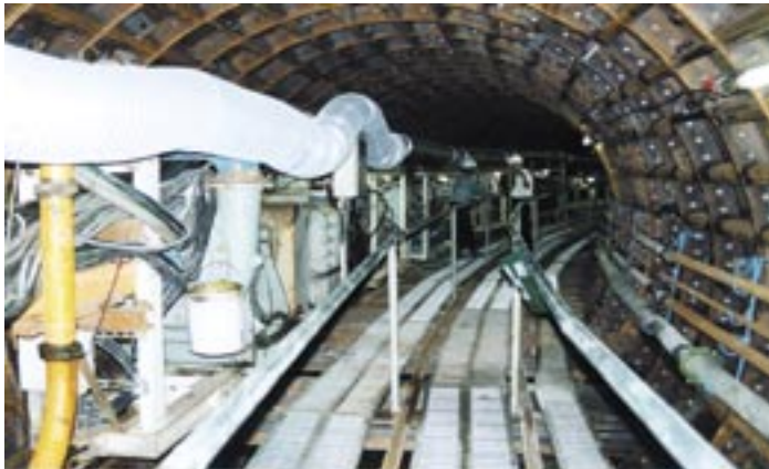
しもじうすいかんせん 下地雨水幹線工事 直けい 3 mの下水道トンネル工事
