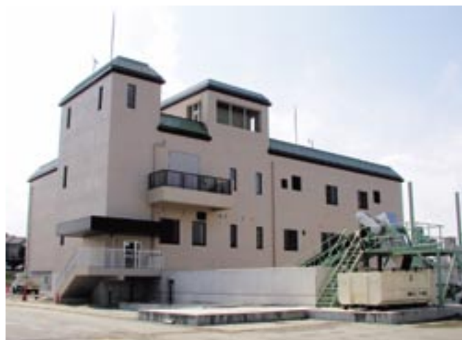
下地ポンプ場 しもじ （H17年3月）
