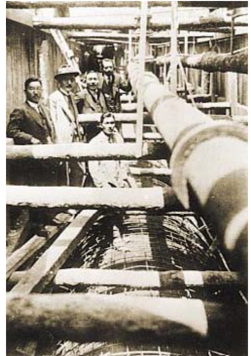
かみでんま かや 上伝馬町と萱町の工事
