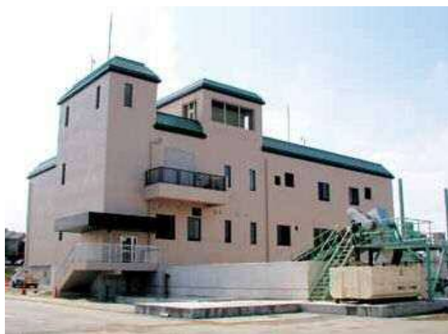
しもじ 下地ポンプ場 2005年(平成17年)3月
