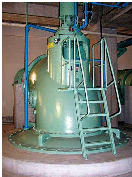
うすい 雨水ポンプ あまみず く あ 大雨のとき、雨水をす早く汲み上げて ほうりゅう 川に放流します。
