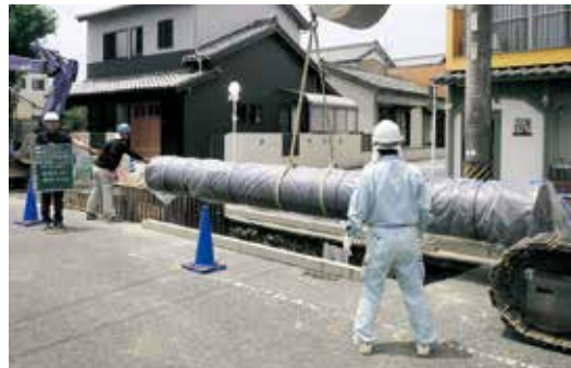
はいすいかん 配水管を道路に埋める工事
