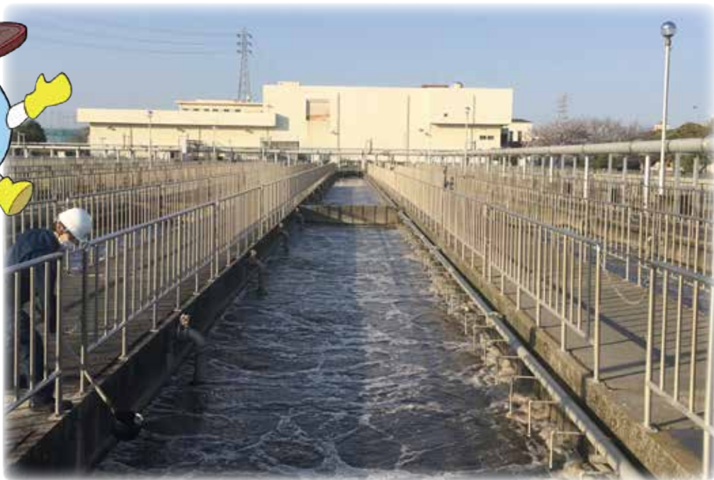
写真:上、 おだかのじょうすいじょう 小鷹野浄水場 下、 なかじまじょう 中島処理場
