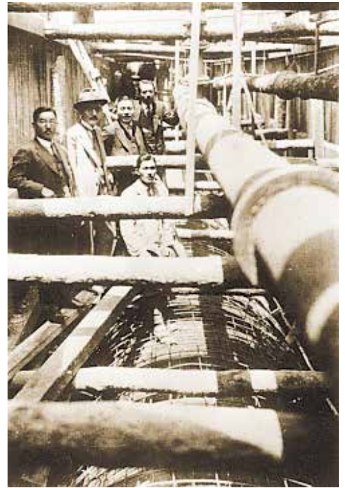
かみでんまちょう かやまち 上伝馬町と萱町の工事
