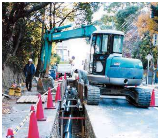
▲下水道管(直径25cm)を埋める工事
