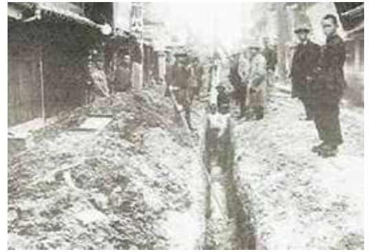
札木通りでの水道工事の様子(昭和2年ごろ)
