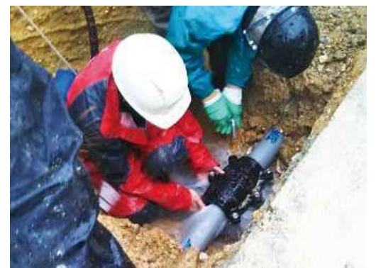
水もれの修理の様子
