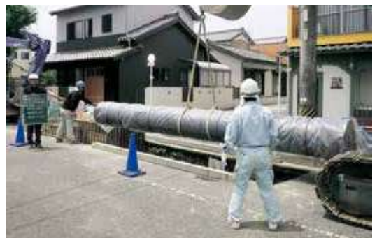
配水管を道路にうめる工事(現在)
