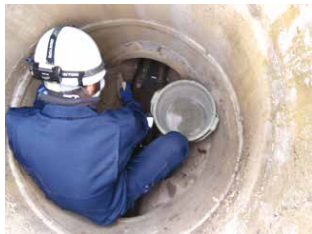
▲下水道管の修理
