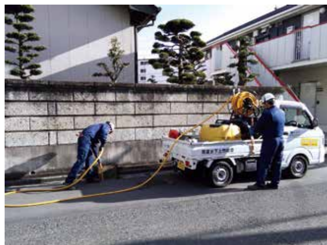
▲下水道管の清掃
