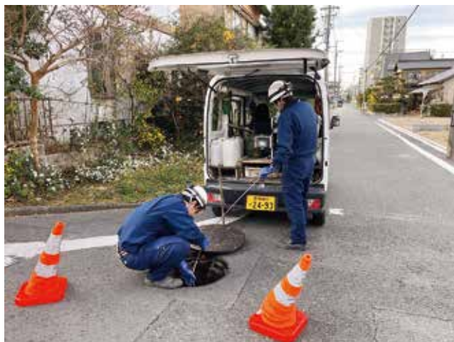
▲下水道管の調査
