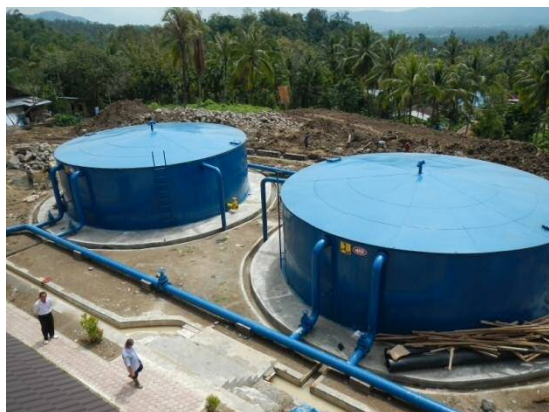
配水設備(配水池)
