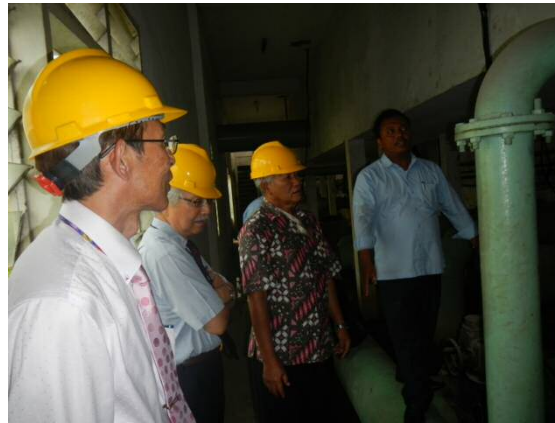
設備保守点検実習
