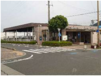
③二川駅南口自転車等駐車場
