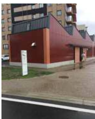
防災ひろば防災備蓄倉庫
