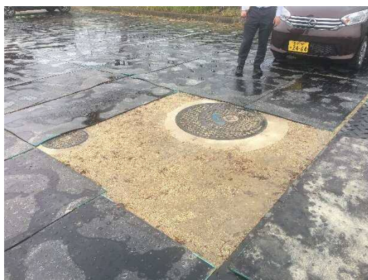
ゴムシートに隠れた取水マンホール
