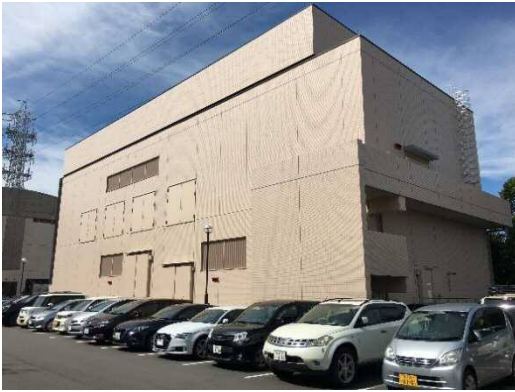
特別高圧変電所の外観
