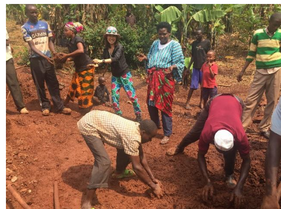
📷：土壁用の土に水を混ぜ、バケツリレーをしている様子。
