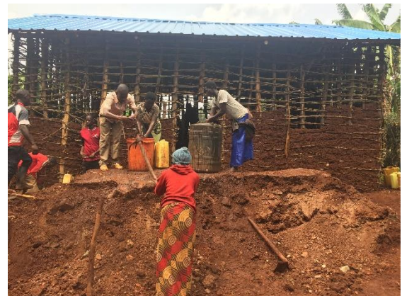
📷：ある日のウムガンダ。大雨で崩れてしまった母子家庭の家を造り直している様子。
