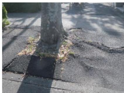
写真 2-5 樹木の根による舗装の持ち上がり
