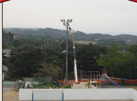
夜間照明取付様子。(8月27日撮影)
