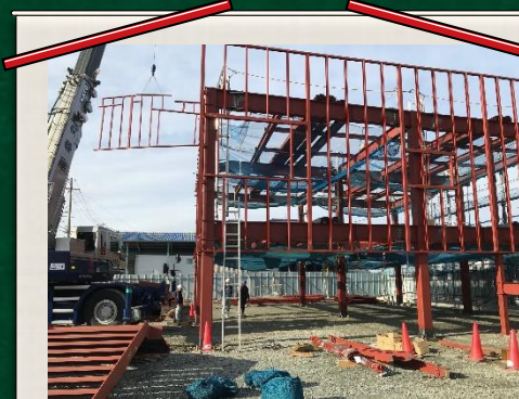
↑ 梅薮防災センター鉄骨建て方の様子
