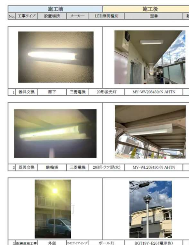
照明器具のLED化による省エネ
