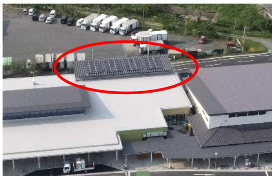
▲太陽光パネルによる非常用電源
