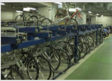
豊橋駅西口地下駐輪場 場内
