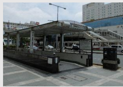
豊橋駅西口地下駐輪場の出入り口
