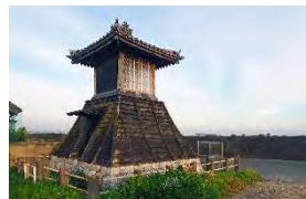
豊川河口部右岸にある燈明台で、海上航行の安全と吉田湊・前芝湊の指針として、寛文 9 年（1669）に吉田藩が建設した。前芝村の村民により毎夜点灯され、災害で幾度も損壊したが、その都度藩により修復されてきた。現在のものは昭和 41 年（1966）に復元されたもので、愛知県の史跡に指定されている。
