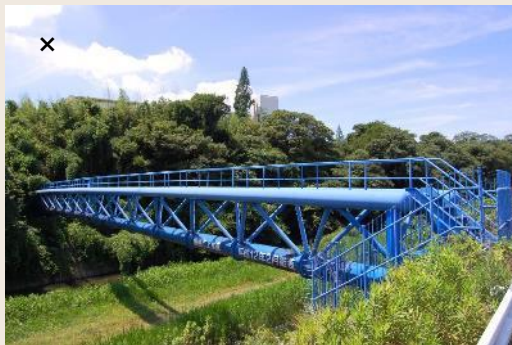
改善前の青い水管橋
