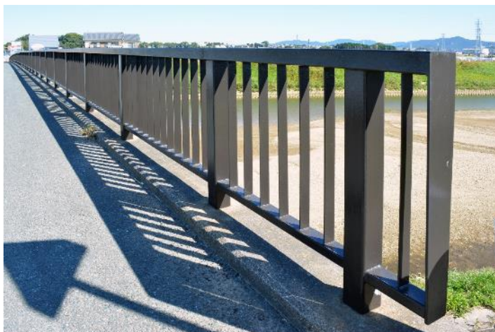
■フラットバーの縦格子の高欄をダークブラウンで塗装した事例：フラットバーの幅やピッチによっては、高欄が壁に見える場合がある。その場合は、塗装色をグレーベージュにするなど、開放感を損ねないよう配慮することが望ましい。
