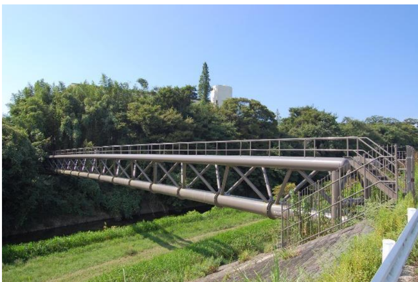
■ 改善後の水管橋 色彩：2.5Y4.0/1.0（上下水道局前）
