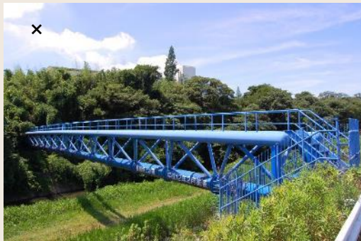
改善前の青い水管橋
