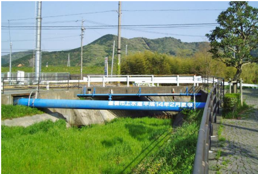
■改善前の水管橋：青い水管橋が自然景観のなかで目立っており、管の文字表示も必要以上に大きく、景観が煩雑に見えます。
