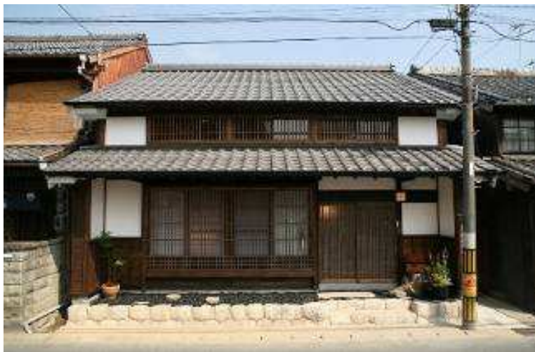
▲ 歴史的建築物の修繕の事例
