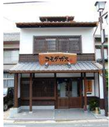
▲ 一般建築物の新築の事例
