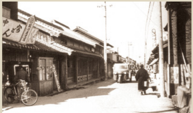
④大岩町字東郷内より西を望む：昭和34年(1959) オート三輪が走るのどかな通り。右のレンガ造りの壁は現在でも見ることができる。
