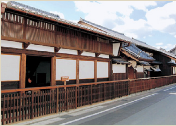
市指定有形文化財 旧旅籠屋「清明屋」(左の建物)
