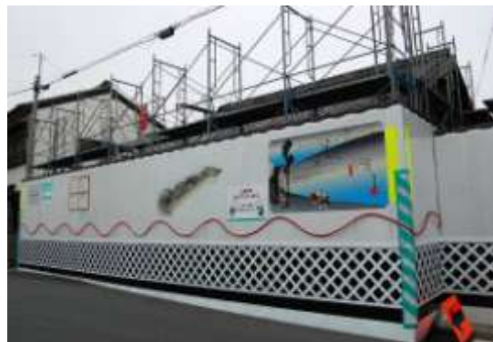
仮囲いがされ工事が始まった駒屋
