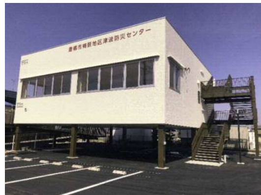
津波防災センター(梅薮地区)
