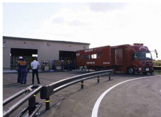
道の駅「とよはし」の防災備蓄倉庫
