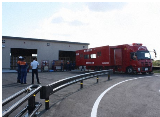
道の駅「とよはし」の防災備蓄倉庫
