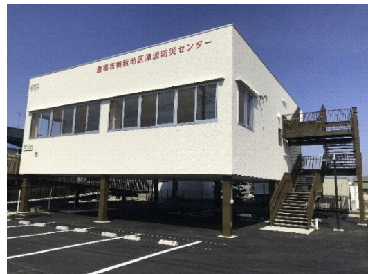
津波防災センター(梅敷地区)
