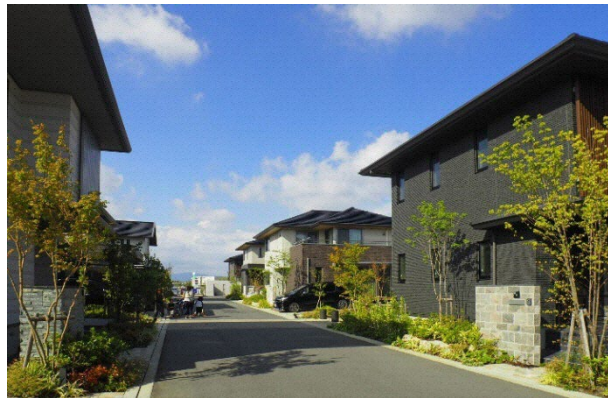
地区計画を活用した住宅地(曙町松並地区)
