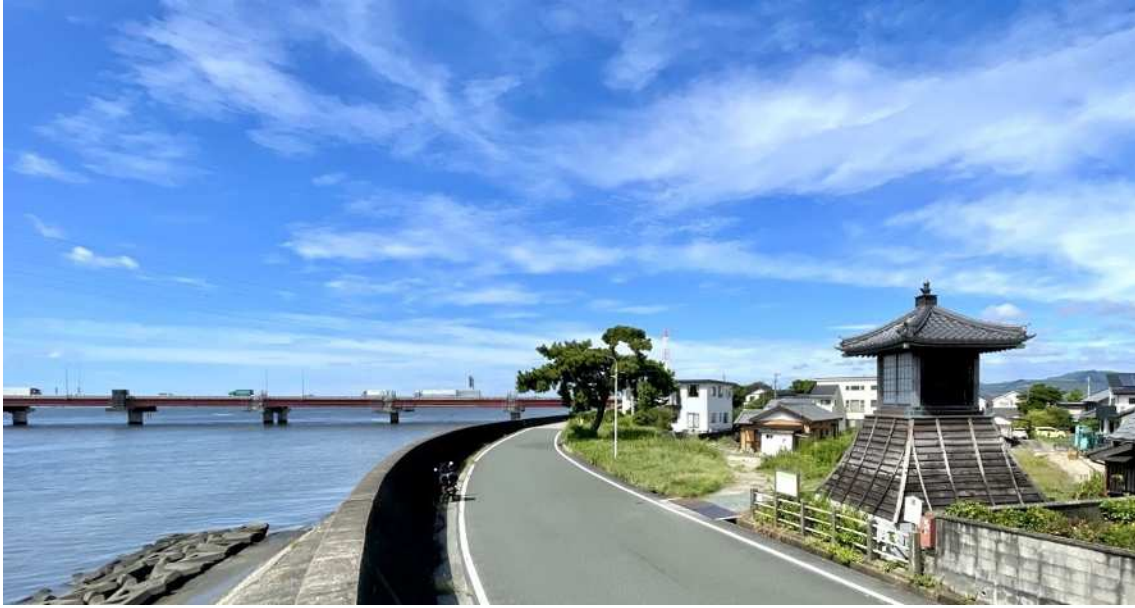
▲ 豊川河口部に建つ燈明台（上流側から河口側を臨む）
