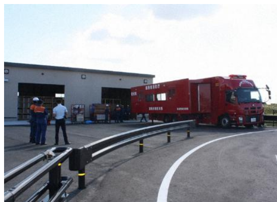
道の駅「とよはし」の防災備蓄倉庫
