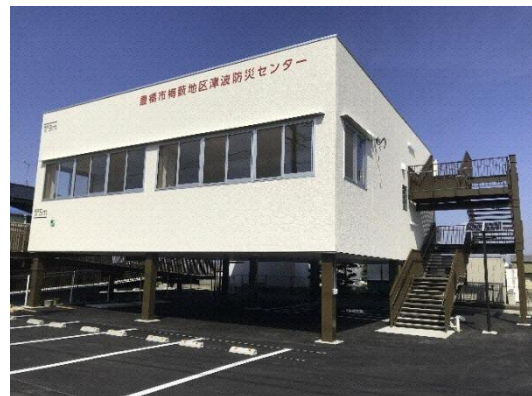
津波防災センター(梅敷地区)
