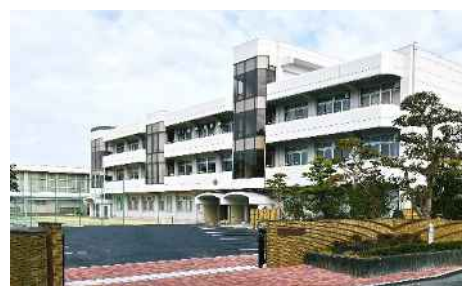
【豊橋市立家政高等専修学校の校舎】
