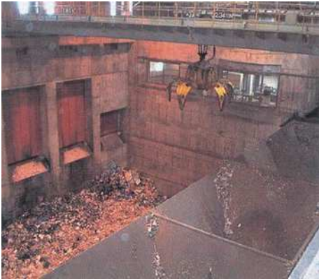
ごみピットの様子
