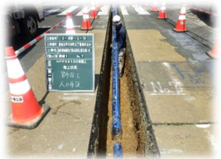
水道管耐震化工事の様子
