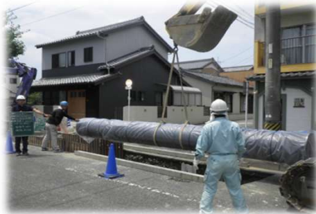
水道管耐震化工事の様子
