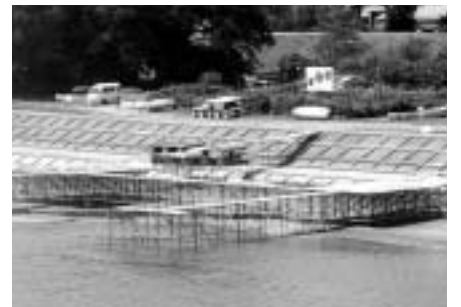
豊川に設けられた打上場
