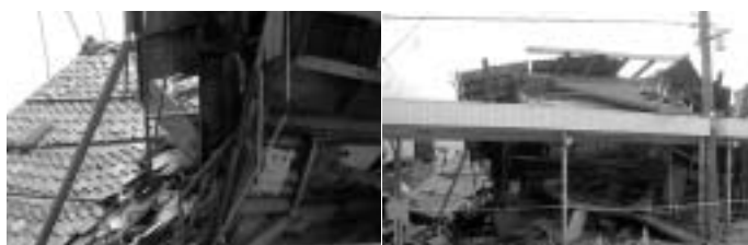
危険の張り紙がされた住宅（柏崎市） アーケードにせまる建物（柏崎市）
