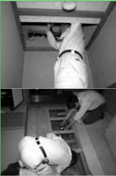
上：屋根裏の骨組を確認しているようす 下：床下の基礎を確認しているようす
